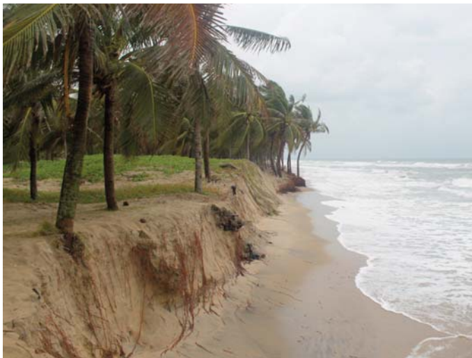
Hình 6: Bờ biển Hội An bị lấn 150m sau 7 năm (ảnh Axel Neubert, HSF)
